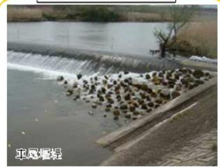
小わざ魚道化された堰堤
